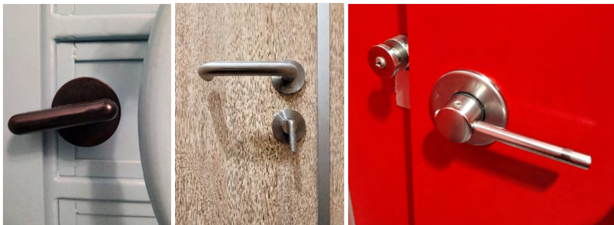
Rysunek 54. Zalecane zamknięcie toalety oraz kabiny (po prawej), ułatwiające obsługę przez osobę z ograniczeniami manualnymi [fot. Katarzyna Guratowska, po prawej – fot. Joanna Kowalewska]
