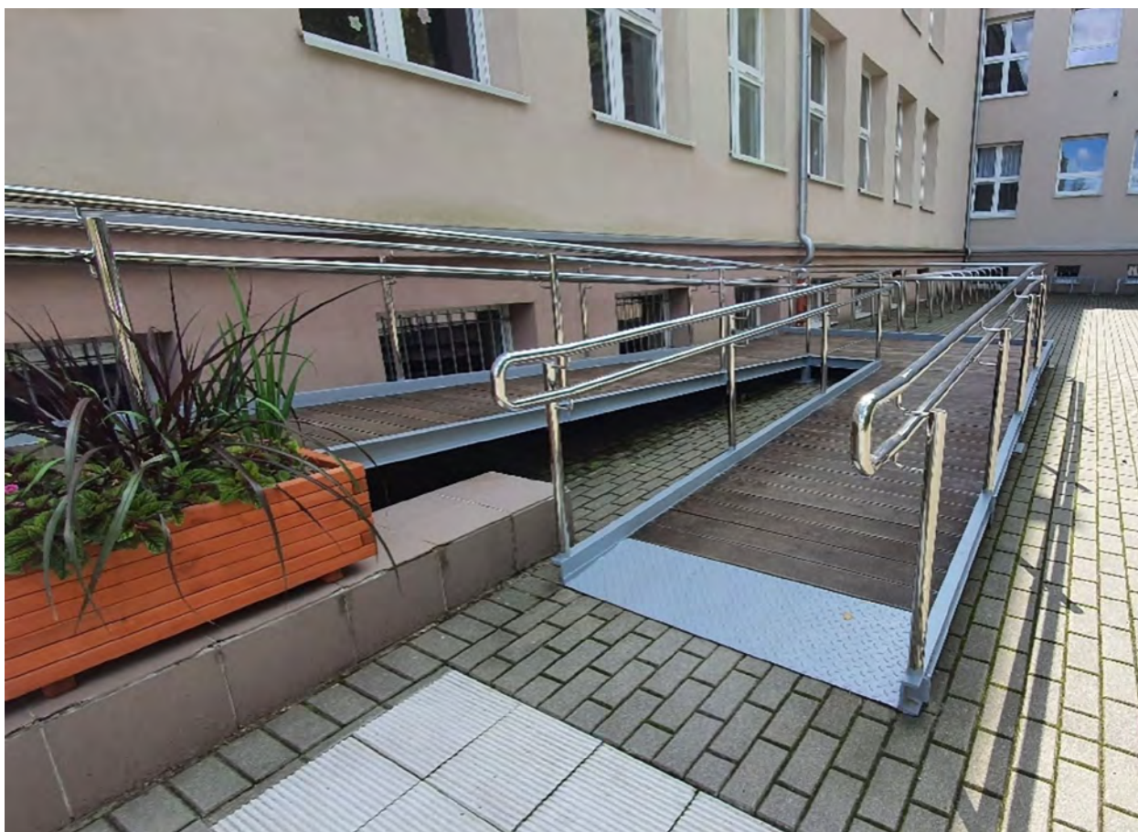
Rysunek 15. Przykład pochylni o nawierzchni wykonanej z desek kompozytowych. SP 16 w Gdyni [fot. Marek Wysocki]
